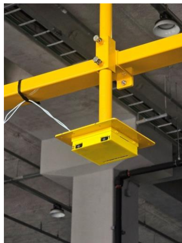
도크 상부 브래킷 설치
